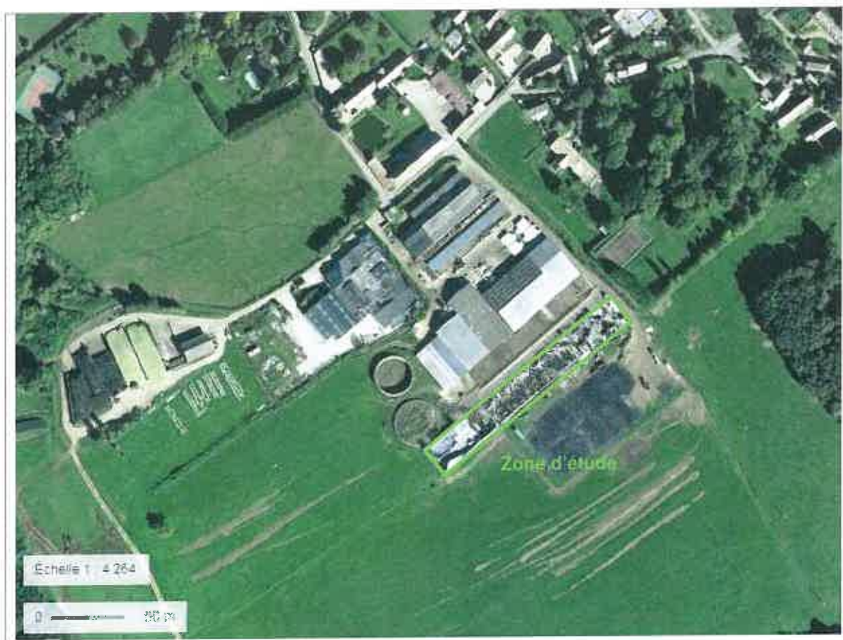
Figure 1 : Localisation géographique et vue aérienne du site (source : Géoportail – photographie de 2015)
